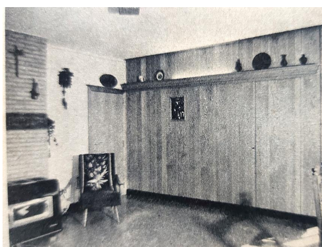
3. De houten wand met ingebouwde werkkast.
