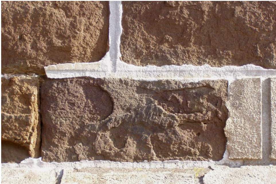
Gelrode St.-Corneliuskerk : negatief effect cementvoeg
