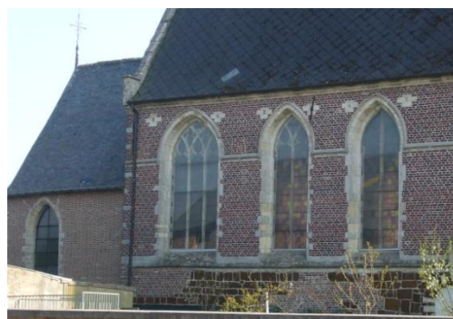
5 6 7 8 de noordelijke muur
